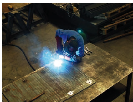
↑ Opération de soudage
